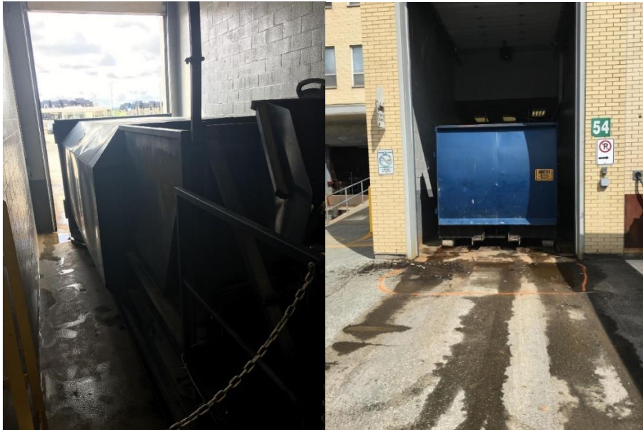
Figure 3.9 Compacteur à déchets accessible par l'intérieur du bâtiment (photos prises par Audrey-Maude Sauvé)
