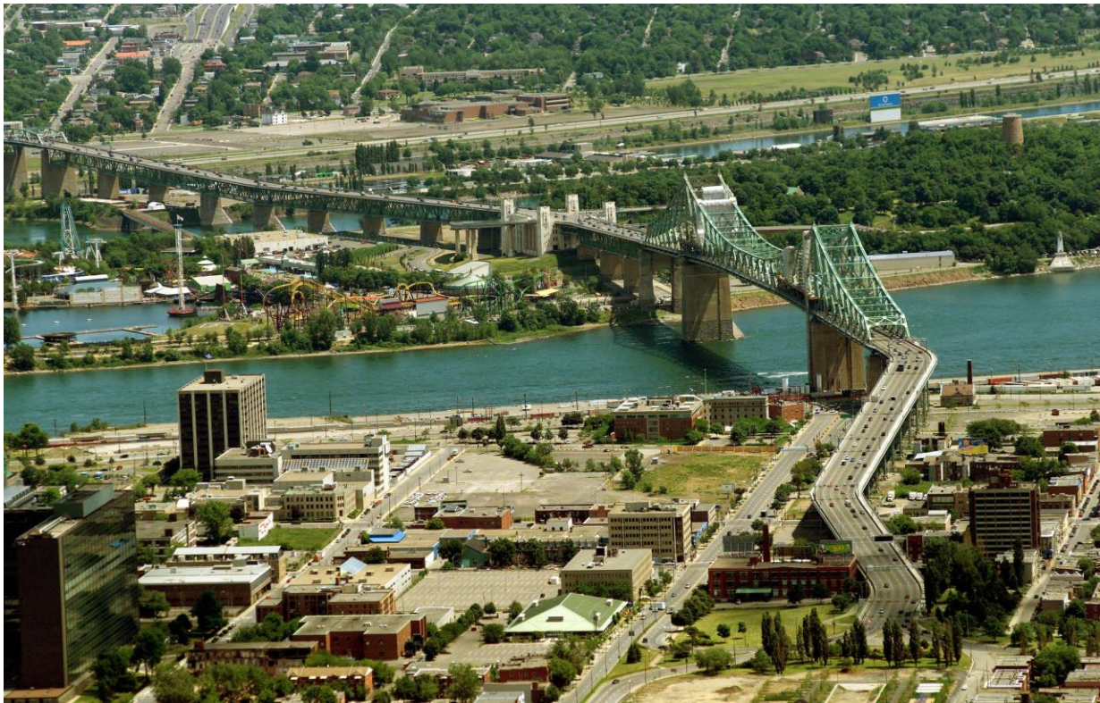
Figure 3: Vue aérienne du pont Jacques-Cartier (flickr PJCCI) 8
