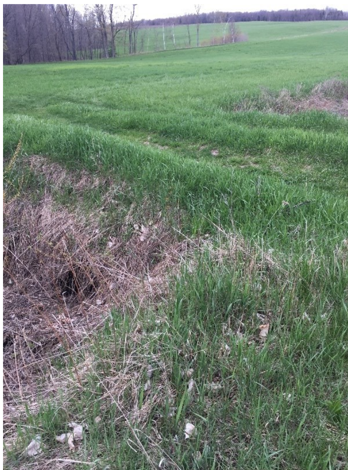
Figure 18 : Ponceau situé dans la zone agricole, près de la forêt, dans le cinquième bassin versant étudié à Compton
