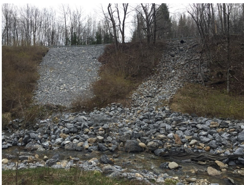
Figure 31 : Enrochement situé dans le segment 4 du ruisseau Hall à Dudswell (source : Antoine Pruneau, 2021)
