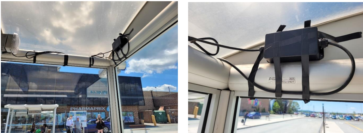
Figure 7 : Photo de l'installation du capteur fixe au carrefour de l'Estrie en juillet 2022
